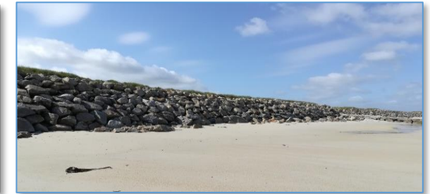
Ouvrage en dur
